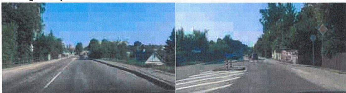
2 pav. Esama krašto kelio Nr. 115 būklė
